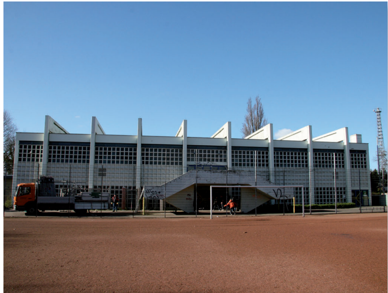
Halle Beberich vor Sanierungsarbeiten am 12. März 2008
