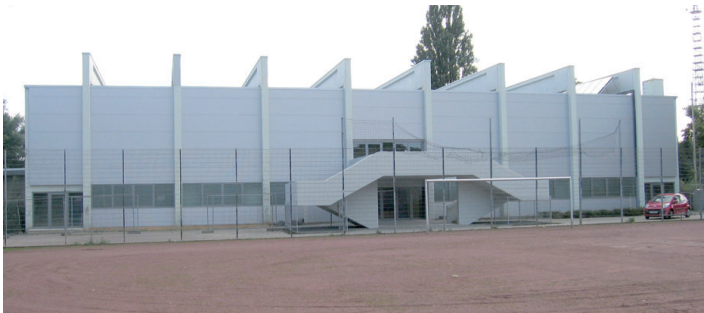
Fertigstellung Sporthalle, außen
