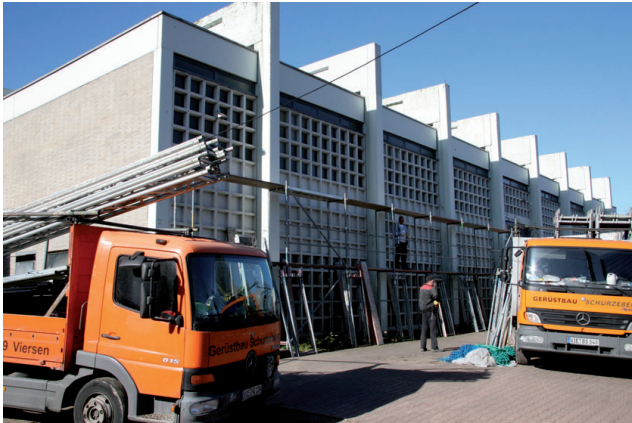
Beginn mit dem Gerüstaufbau am 12. März 2008
