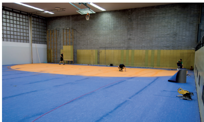
Einbau des Sportbodens mit farblichen Schusskreisen
