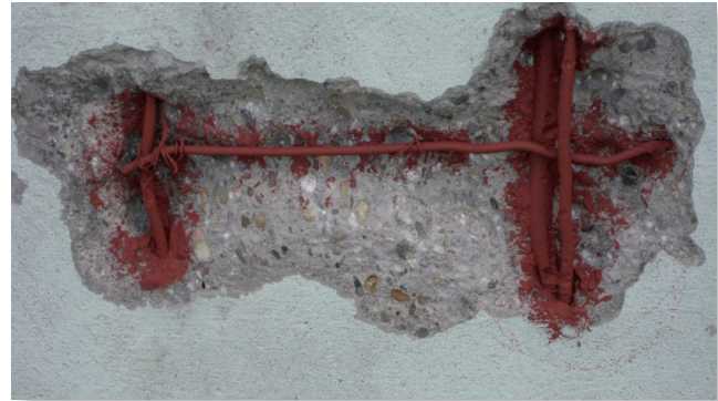
Betonsanierung Schadensbehebung
