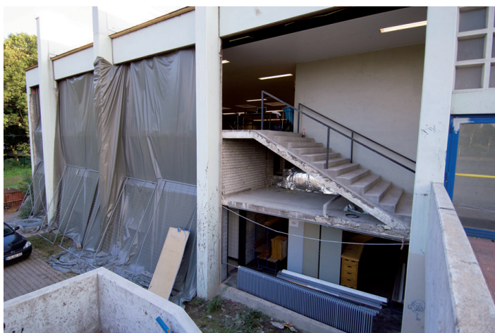
Beginn mit den Abbrucharbeiten am 24. Juni 2008
