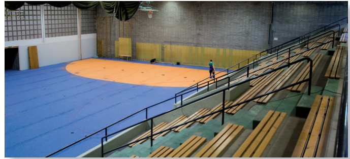
Fertigstellung Sporthalle, innen
